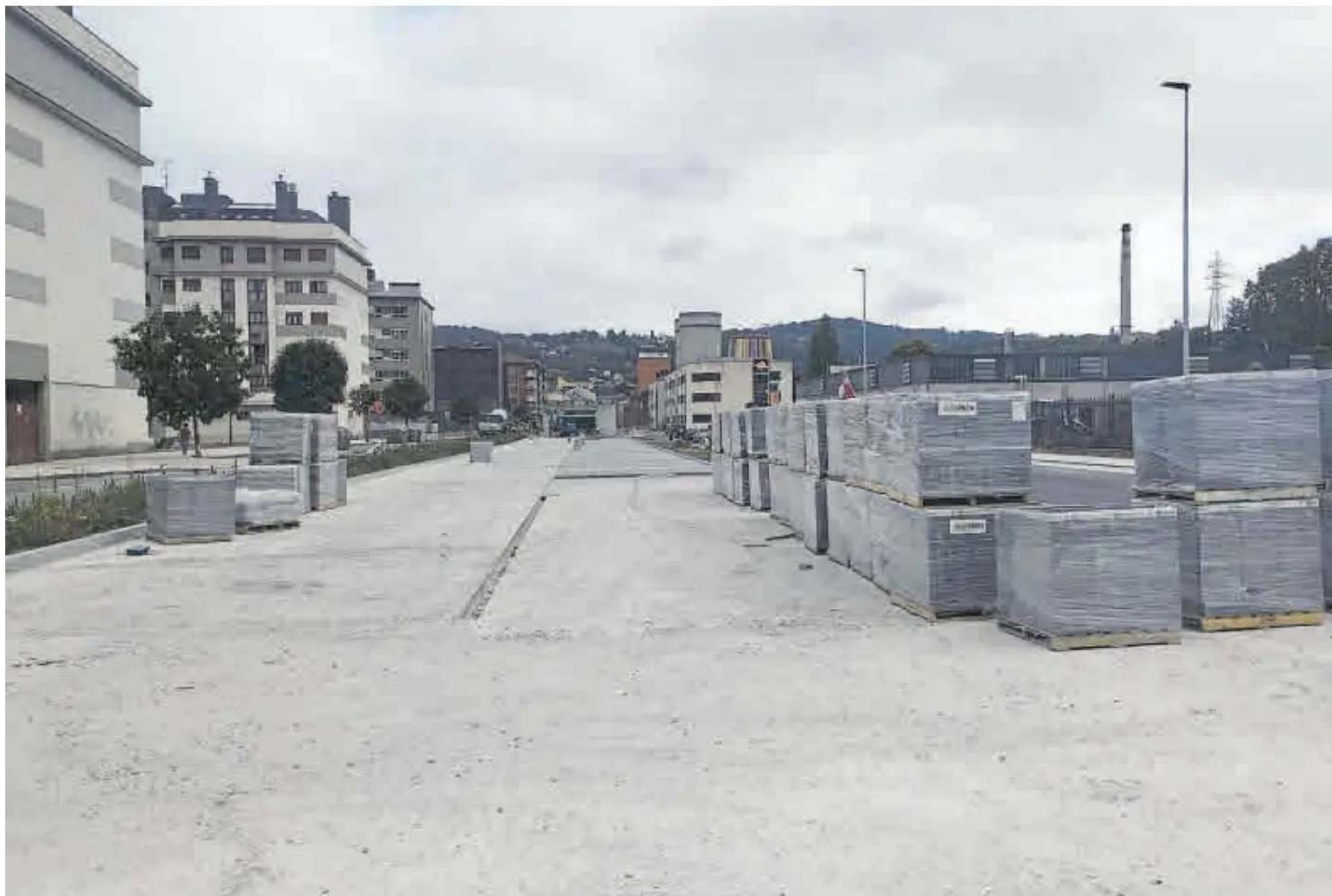
Trabajos de pavimentación del bulvar en las inmediaciones de Valnalón.
