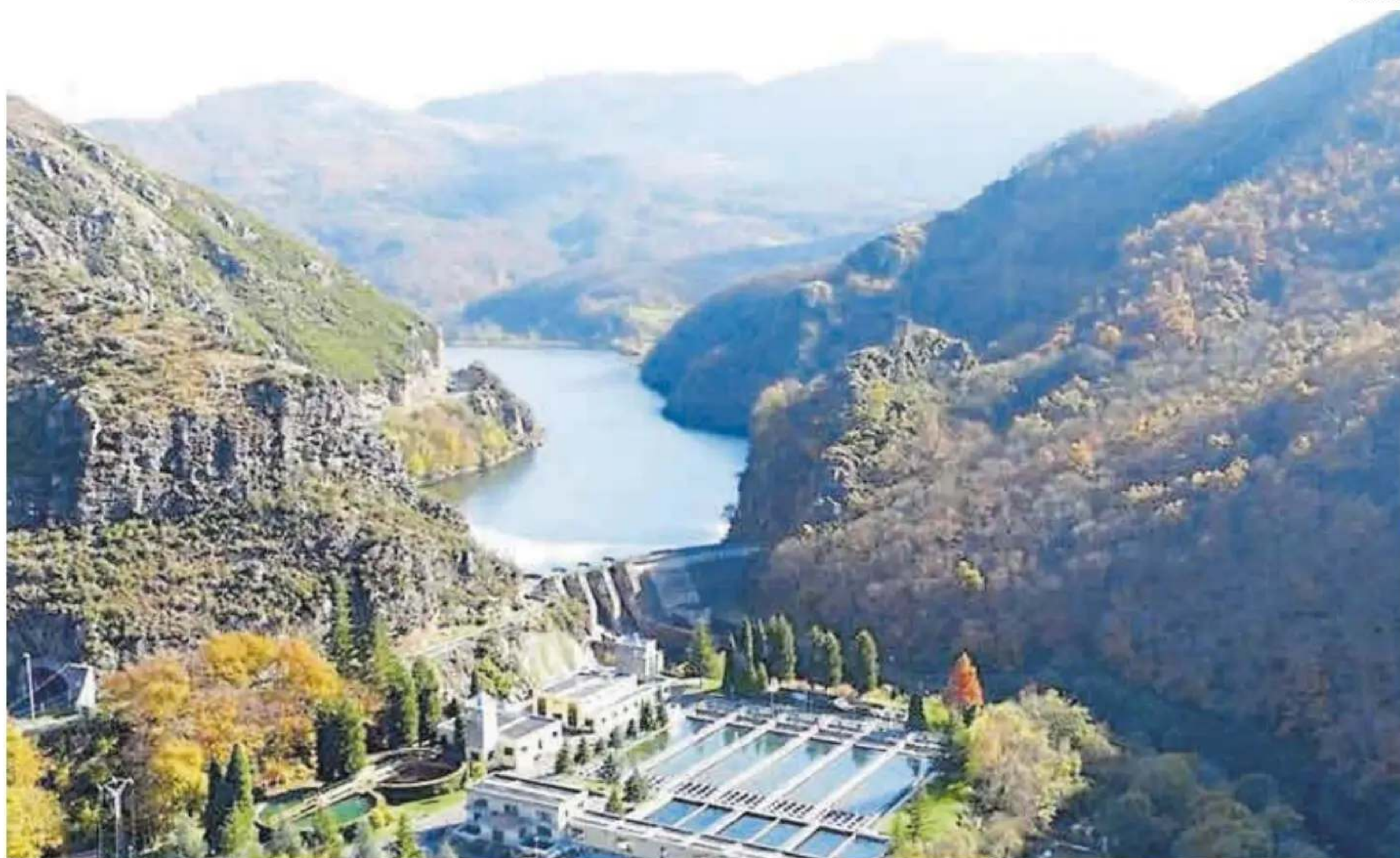
La potabilizadora en primer término, con el embalse de Rioseco al fondo.
